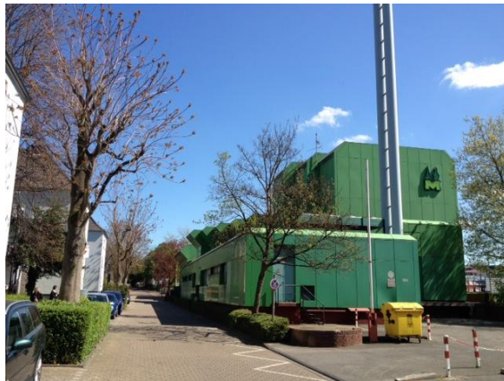
Gottfried-Wetzel-Straße Richtung Osten
